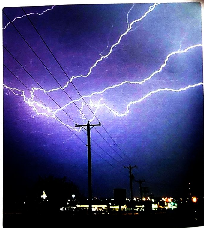
Piorun uderzający w słup linii energetycznej
